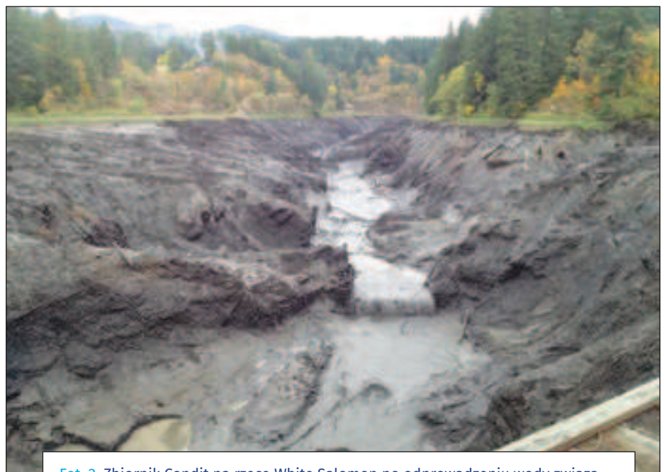
Fot. 2. Zbiornik Condit na rzece White Salomon po odprowadzeniu wody związanej z rozbiórką stopnia wodnego – http://www.nwrafting.com/
