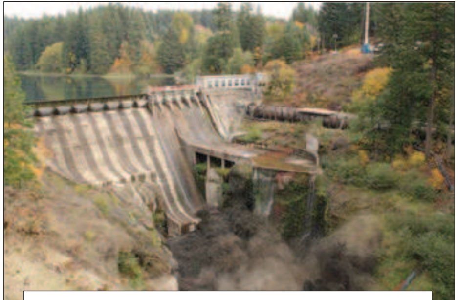
Fot. 1. Opróżnianie zbiornika z osadów dennych ze zbiornika Condit na rzece White Salomon przeddzień rozbiórki stopnia wodnego – www.oregonlive.com
